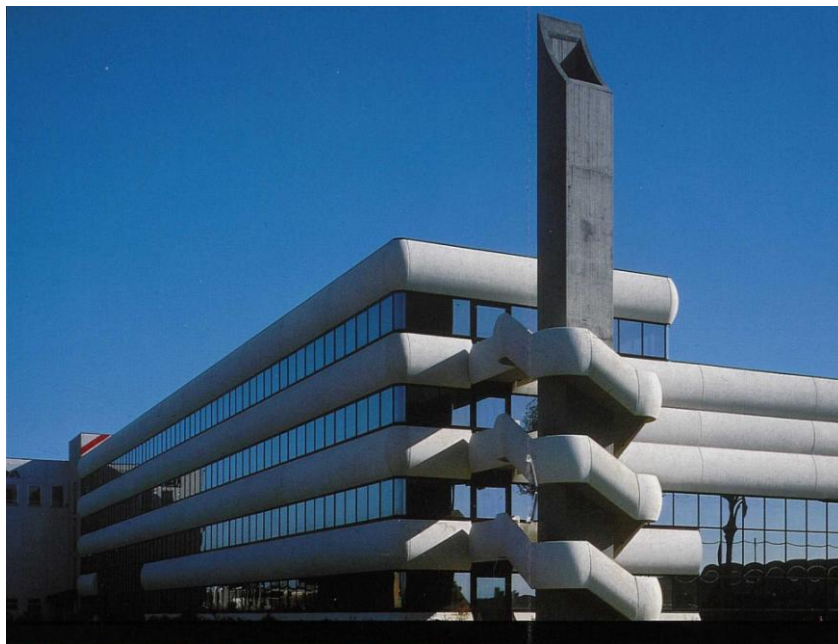
Fig. 12 Pannelli prefabbricati del Centro direzionale Schiavi a Piacenza
