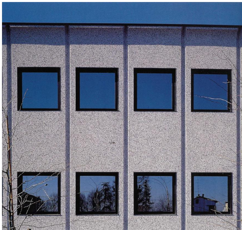
Fig. 11 Parete a pannelli prefabbricati in graniglia colorata faccia-a-vista
