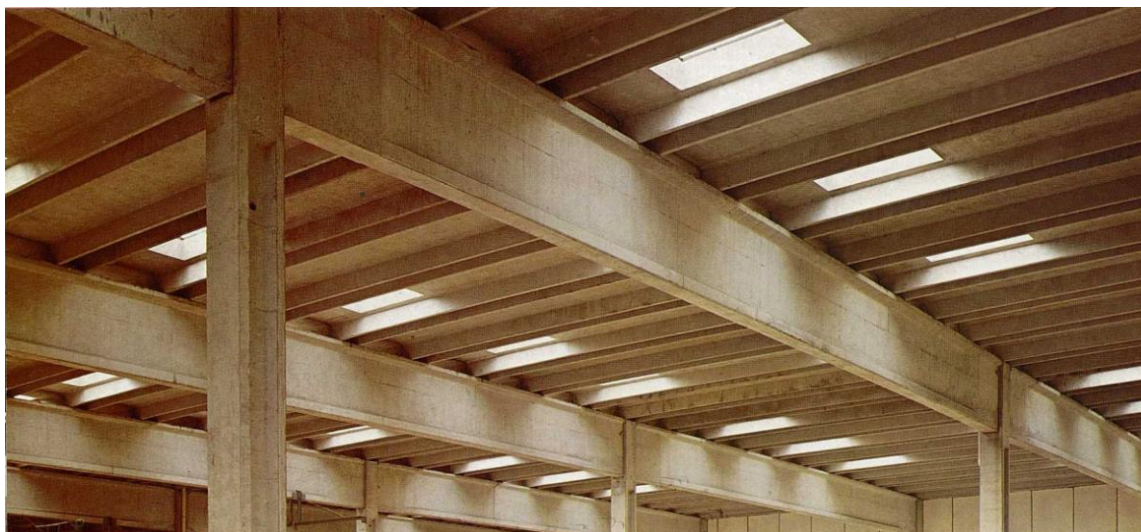
Fig. 3 Copertura di edificio industriale con travi in cap e pannelli nervati
