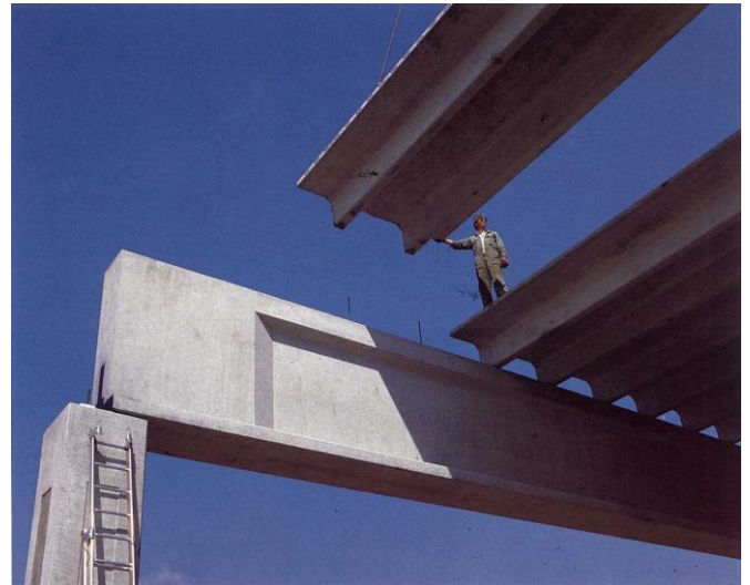
Fig. 5 Posa di "tegoli a pi-greca"
