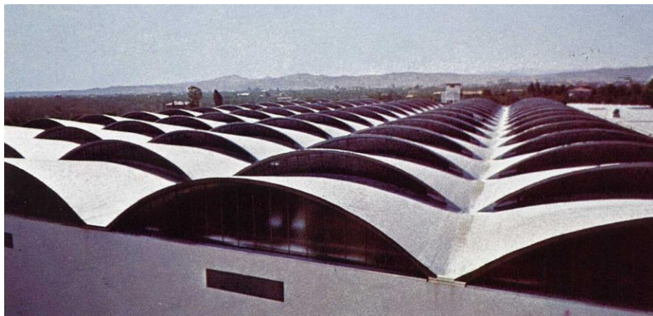
Fig. 2 Copertura con volte a shed in laterocemento
