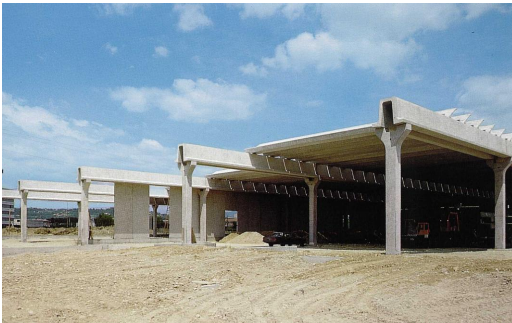
Fig. 14 Stabilimento Campagnolo a Vicenza, in costruzione, con travi a \Omega e voltine a shed di copertura
