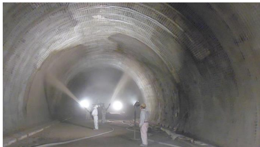
rinforzo con rete in acciaio
