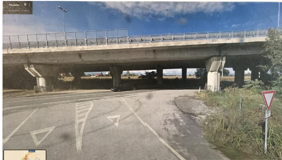
Situazione Ante Crollo
